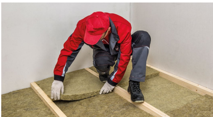
Рис. 2. Монтаж теплоизоляции враспор между лагами
