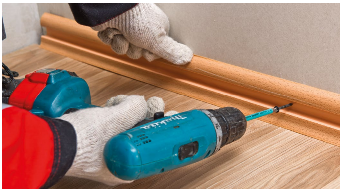
Рис. 16. Крепление плинтуса
