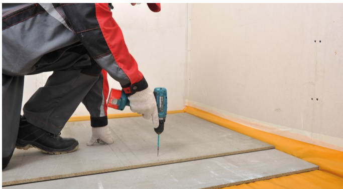
Рис. 9. Устройство сборной стяжки
