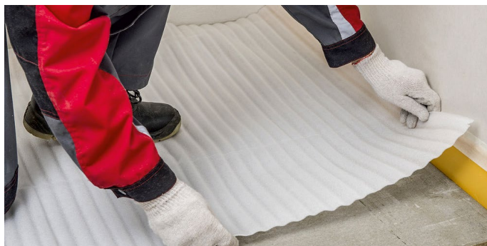
Рис. 12. Укладка подложки под финишное покрытие пола
