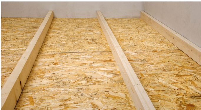
Рис. 1. Подшивка лаг снизу
