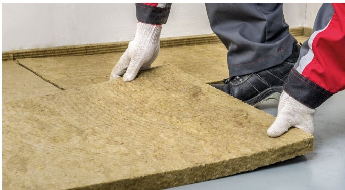
Рис. 7. Укладка плит ТЕХНОФЛОР СТАНДАРТ
