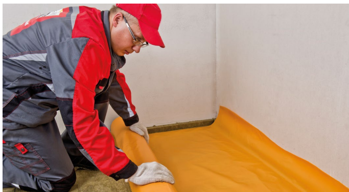
Рис. 8. Укладка гидроизоляции
