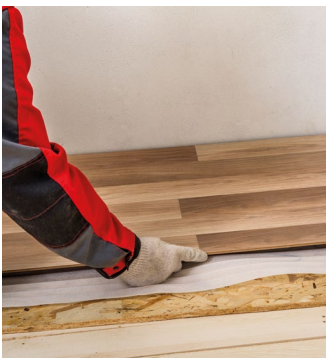
Рис. 5. Монтаж чистового покрытия
