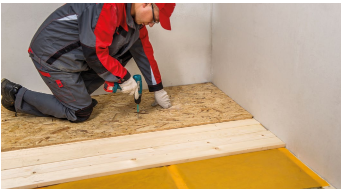
Рис. 4. Монтаж черного пола
