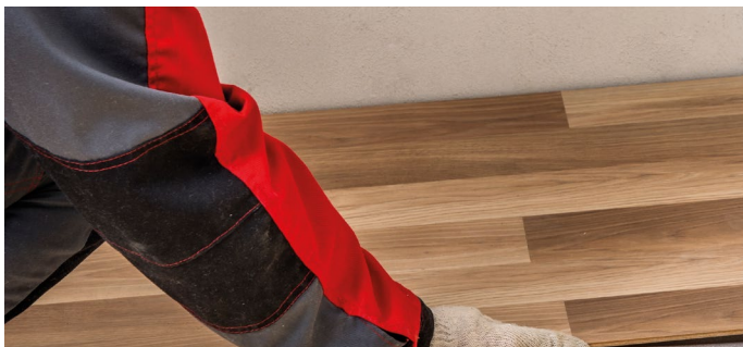
Рис. 13. Монтаж планок ламината
