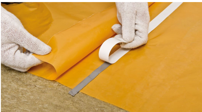
Рис. 3. Монтаж и проклейка нахлестов пароизоляционной пленки
